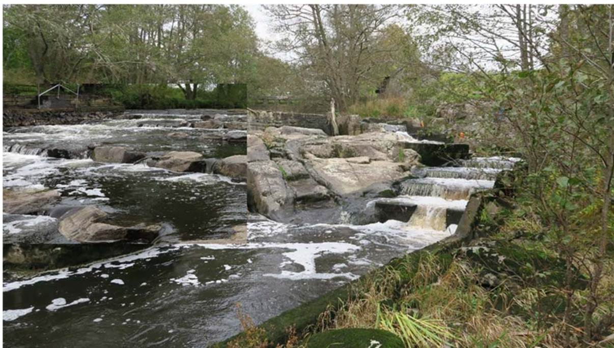
Bild 7. Fotomontage som gestaltar en tänkt semiartificiell strömsträcka en s.k. Pool & traverse. Bilden ger dock inte åtgärden riktig rättvisa, då fallet vid Tegneby är mycket brantare än fallet på bilden (fotomontage Lars Pettersson).
