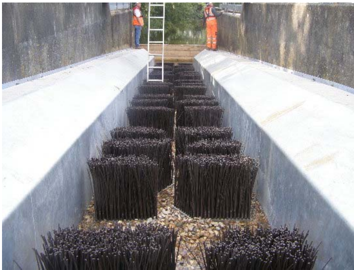
Bild 6. Borstränna. Brush fishway http://www.allingtonlock.co.uk
