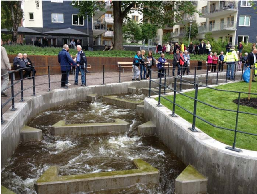
Bild 4. Slitsränna i Norrköping, Motala ström (foto Lars Pettersson).
